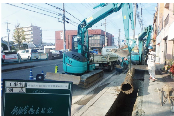
老朽管撤去状況
